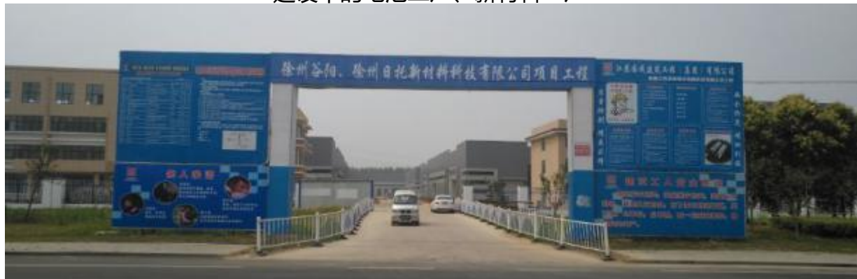
建设中的电池二厂、新材料一厂
